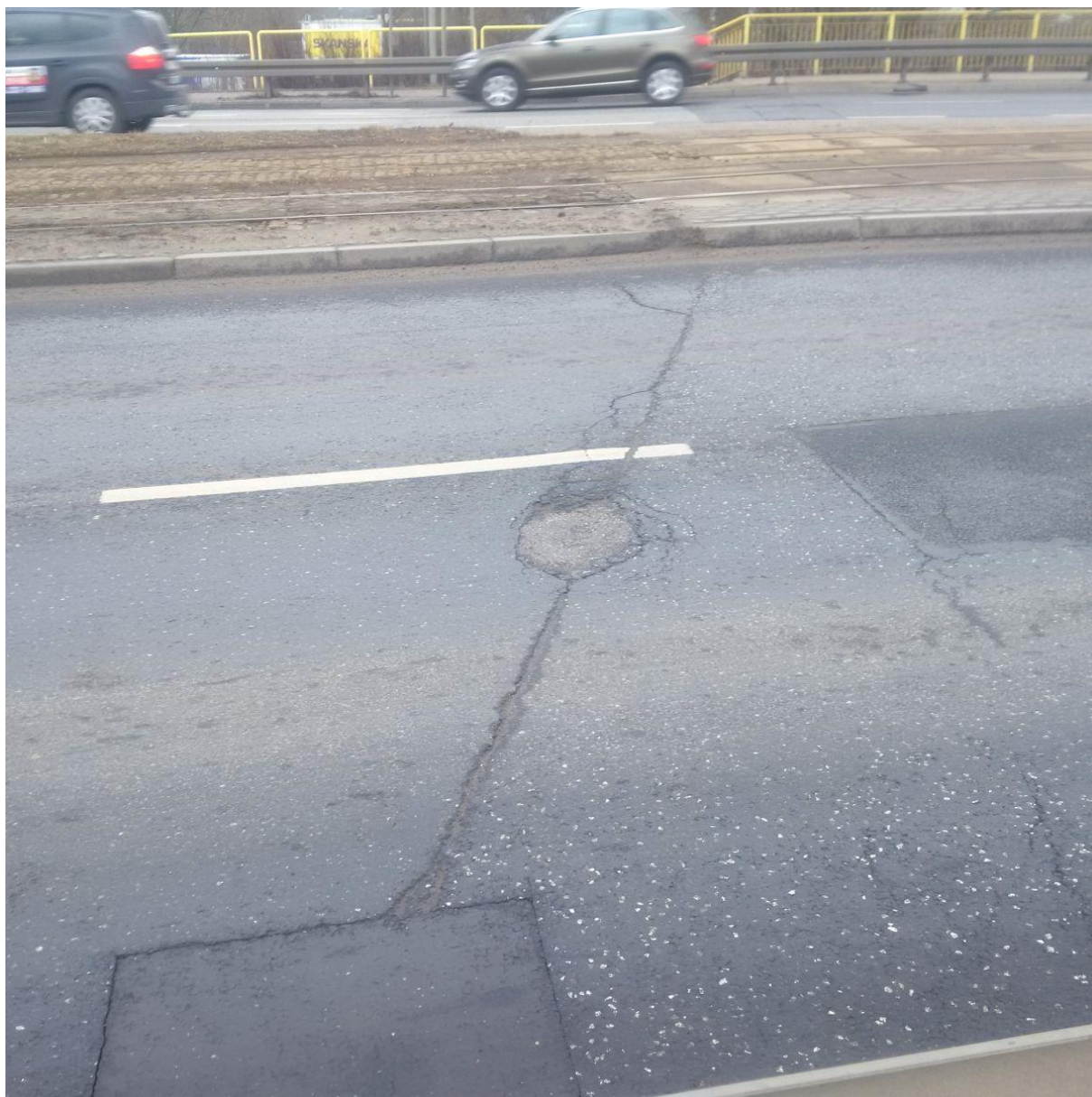
NAPRAWY NAWIERZCHNI BITUMICZNYCH NA OBIEKTACH MOSTOWYCH
