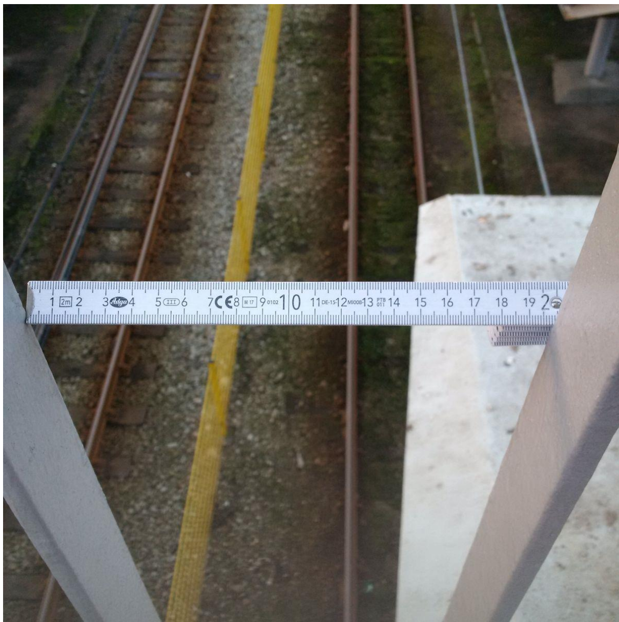
KŁADKA NAD UL. WOJSKA POLSKIEGO – BALUSTRADA DO UZUPEŁNIENIA
