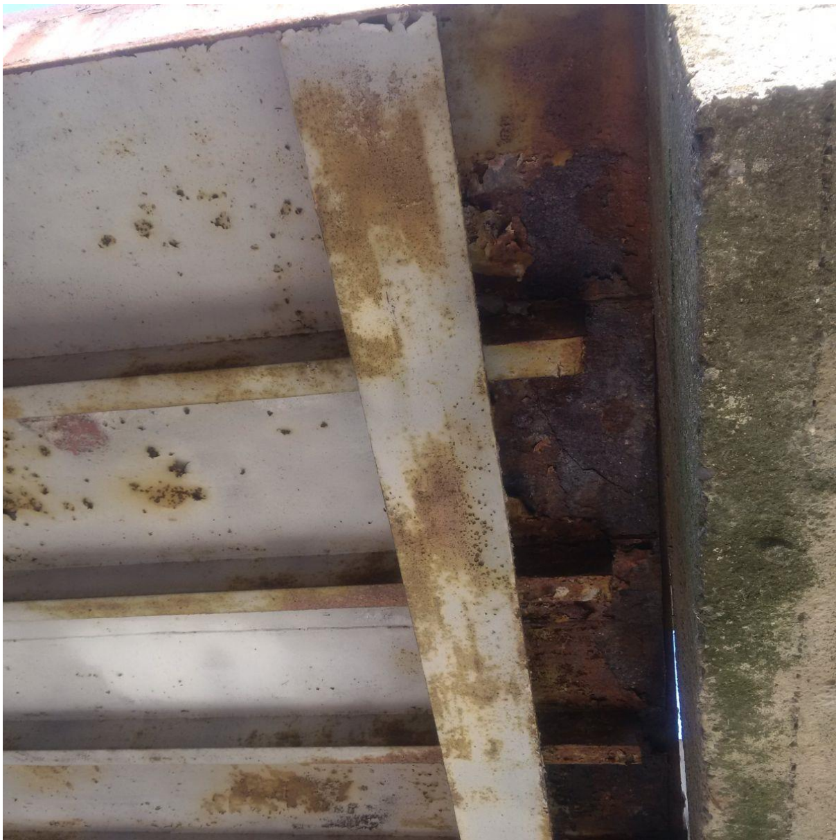
KŁADKA ZINTEGROWANA Z WIADUKTEM KOLEJOWYM NAD ULICĄ GRUNWALDZKĄ – BALUSTRADA DO ODTWORZENIA
