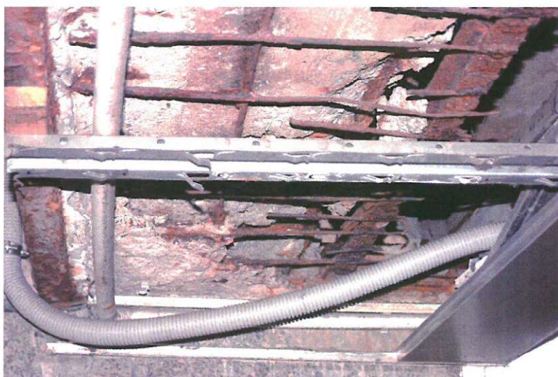
Zbliżenie na skorodowane zbrojenie
