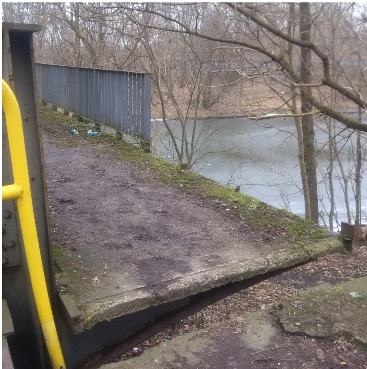
DAWNY MOST KOLEJOWY NAD KANAŁEM BYDGOSKIM W REJONIE UL. PILECKIEGO – BALUSTRADA DO UZUPEŁNIENIA
